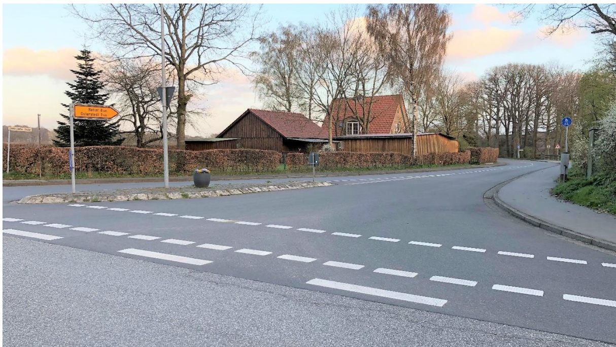
Abbildung 16: Straßen und Wege Todenbüttel (Quelle: eigene Aufnahme, 2021)
